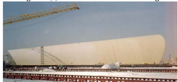
Figure 8 (d) –Installation at Final Position
